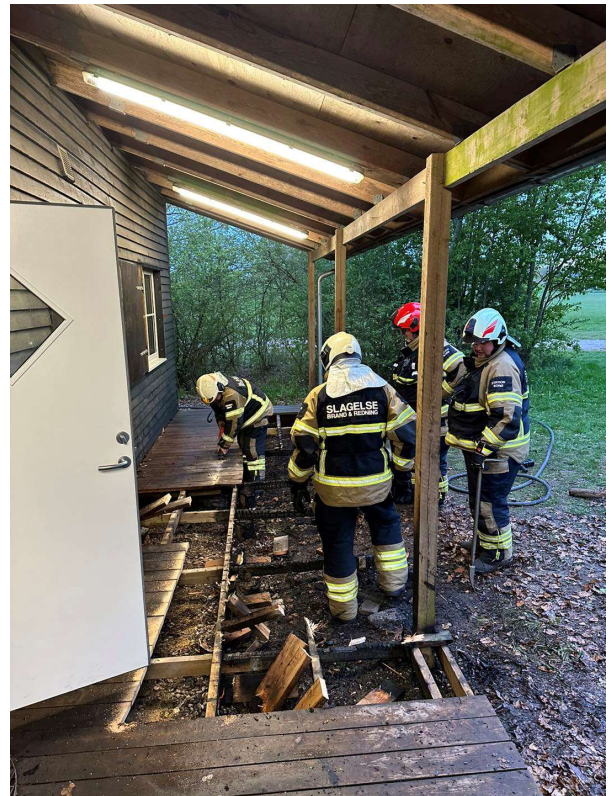
Det kunne nemt være gået rigtig galt, men heldigvis var det kun terrassen som brændte
